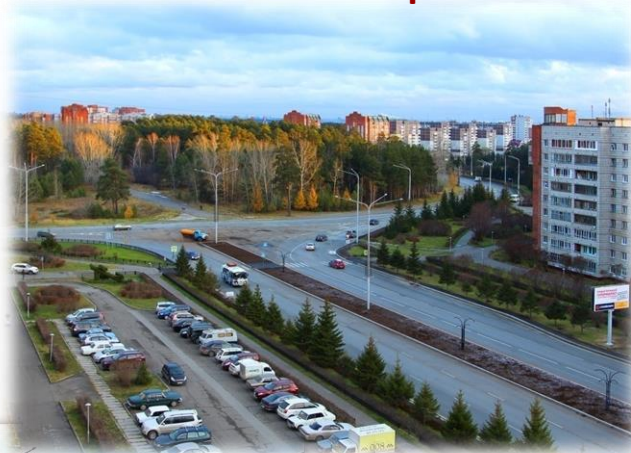
После выполнения работ
